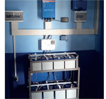
Installation électrique par un système photovoltaïque pour le CSB1 «Manakaravavy», Puissance disponible : 1600VA.
