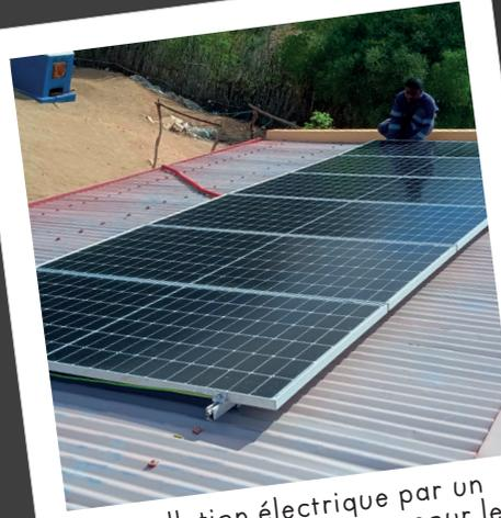
Installation électrique par un système photovoltaïque pour le centre CSB1 «Ampitanaka», Puissance disponible : 2000VA.
