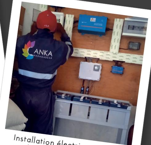
Installation électrique par un système photovoltaïque pour CSB2 «Ankilimivory», Puissance disponible 1200VA.
