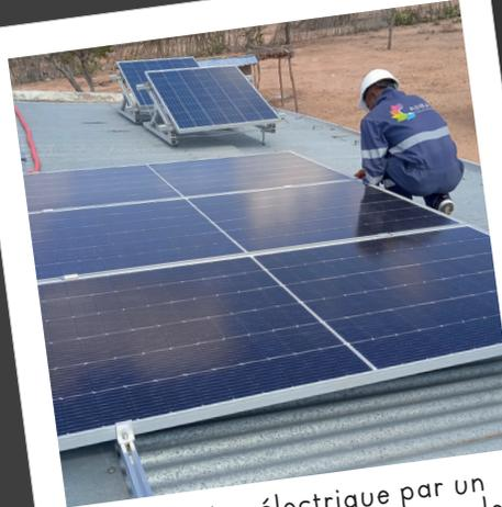
Installation électrique par un système photovoltaïque pour le CSB1 «Sakamasay», Puissance disponible 1200VA.
